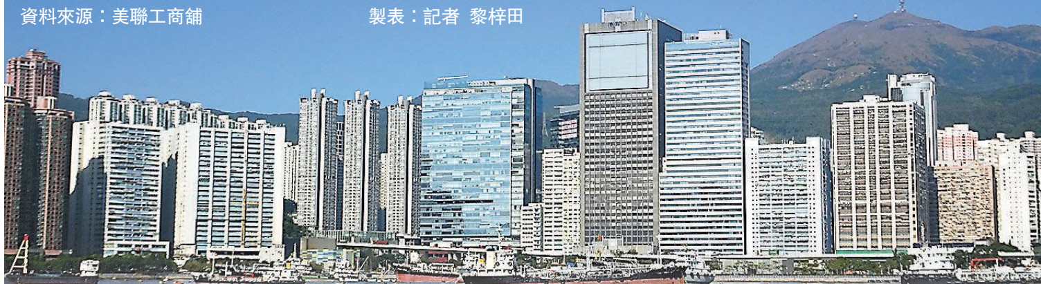
■荃灣區部分工廈坐擁海景，吸引投資者及發展商將其重建為甲廈或住宅。 資料圖片
