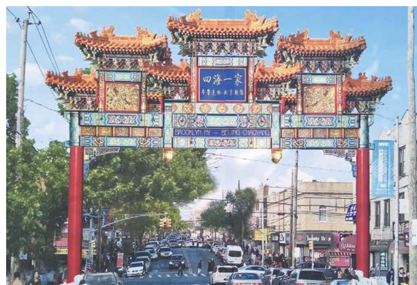
“四海一家”牌樓全景圖
