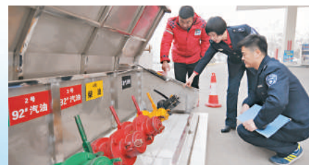
河北省邢台市環保局執法人員在橋西區一家加油站檢查油氣回收設施。
