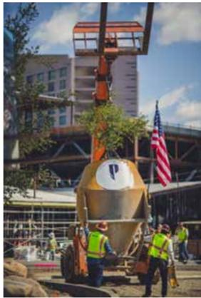
於平頂儀式上，建築團隊在 14 層樓高的位置將最後的 710 噸混凝土建材傾瀉入新建酒店塔樓的頂部框架。新增的酒店塔樓將可容納 568 間客房及酒店套房。一個龐大尤如中型轎車大小的吊桶將盛滿混凝土並被起重機提升至酒店南側樓頂部，然後吊桶中的混凝土全部注入側樓框架中。與此同時，一棵神聖的橡樹幼苗也與吊桶一起被運送至建築樓頂，並作為力量及毅力的象徵擺放在塔樓頂端。當擴建工程竣工後，這棵用於禮儀的橡樹將被種植在度假村的土地上。
